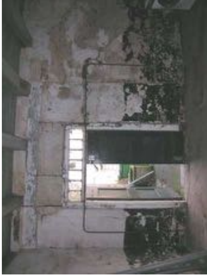
Afbeelding 92. Het koetshuis, gezien naar de achtergevel. In de achtergevel was oorspronkelijk een grotere doorgang aanwezig.
