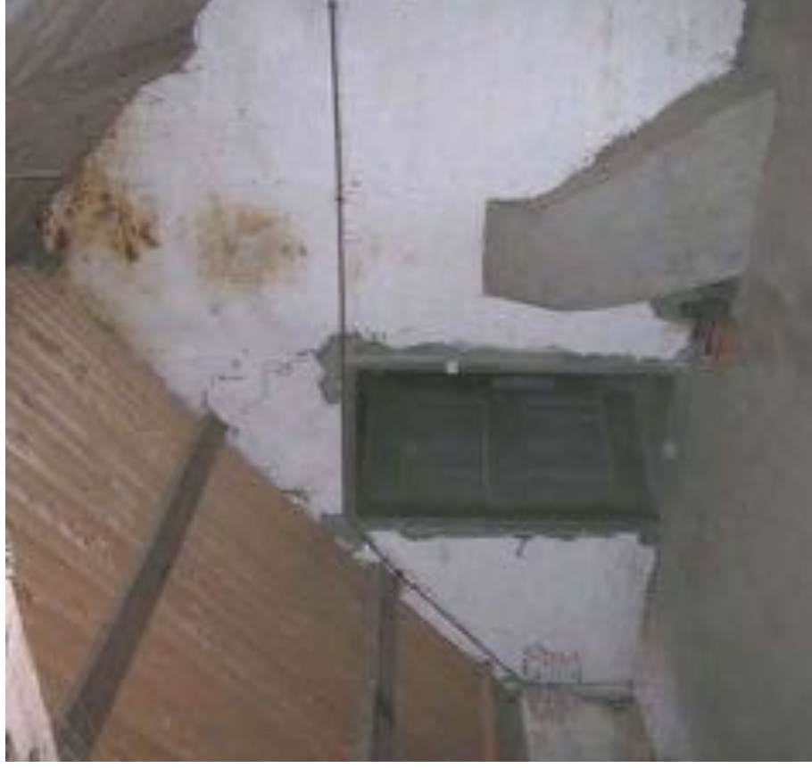
Afbeelding 141. Zicht vanaf de zolder boven de paardenstal in de richting van de brandmuur met het voorhuis. Links is een recentelijk vernieuwd deel van het dakbeschot zichtbaar.
