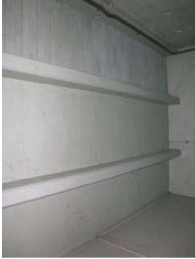
Afbeelding 110. Enkelvoudige balklaag boven de bijkeuken.
