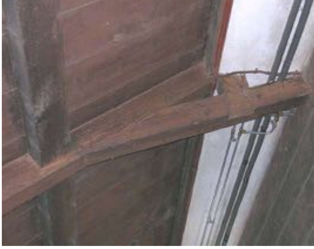
Afbeelding 143. Detail van de vorige afbeelding met de grenen kapspanten. De kap kent geen telmerken of hergebruikt hout en werd in één bouwfase in de late 19 de eeuw aangebracht.
