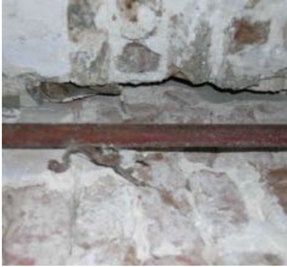
Afbeelding 16. Bouwspoor 18. Detail van de vorige afbeelding met in de bouwnaad aan beide muurdelen glad pleisterwerk.
