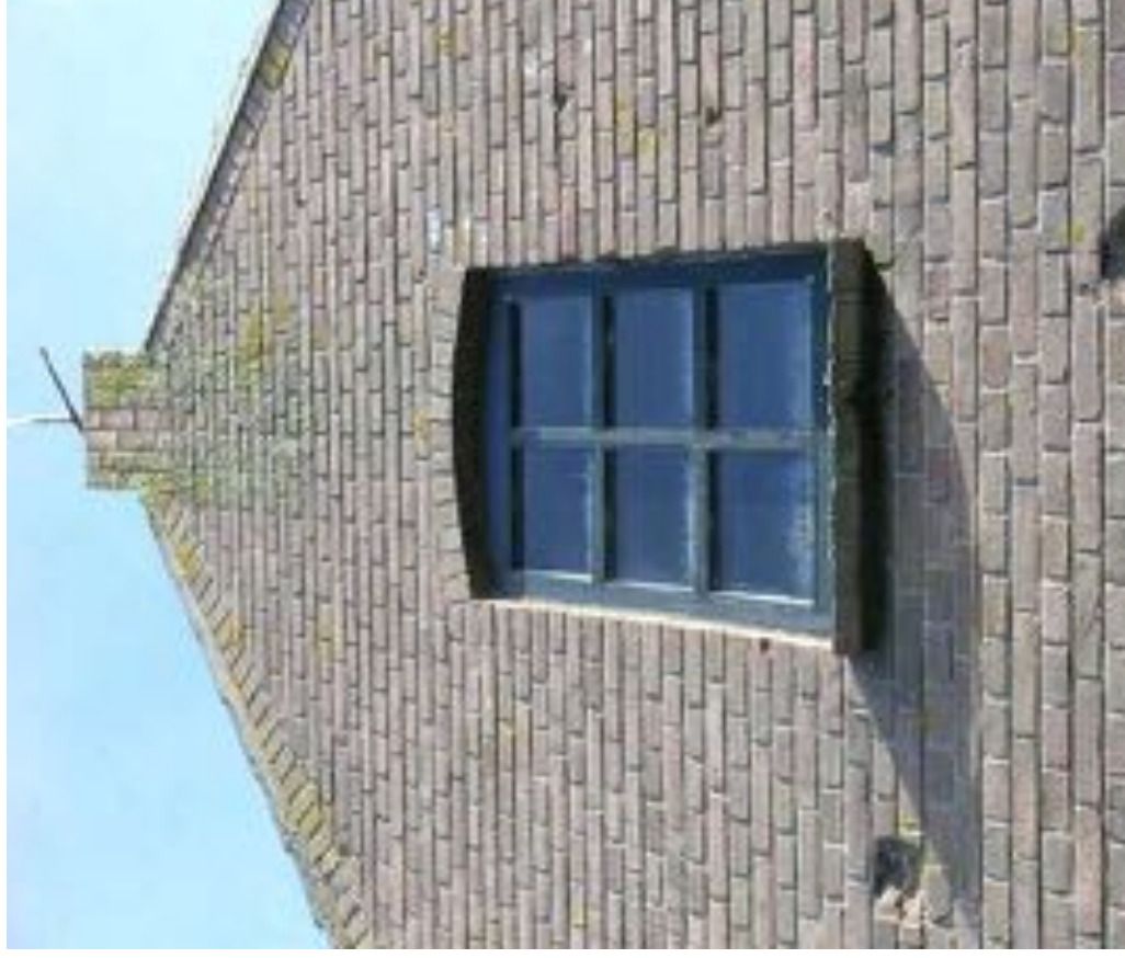
Afbeelding 45. Detail van de vorige afbeelding met de geveltop en granaatinslagen uit de Tweede Wereldoorlog.
