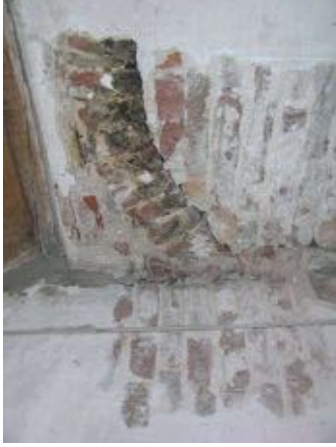
Afbeelding 133. Detail van de binnenhoek tussen de brandmuur van het voorhuis en de scheidingsmuur met het achterhuis. Rechts is een dichtzetting van een oudere – beroete – segmentboog zichtbaar. Deze boog komt uit op de zolder boven de keuken.
