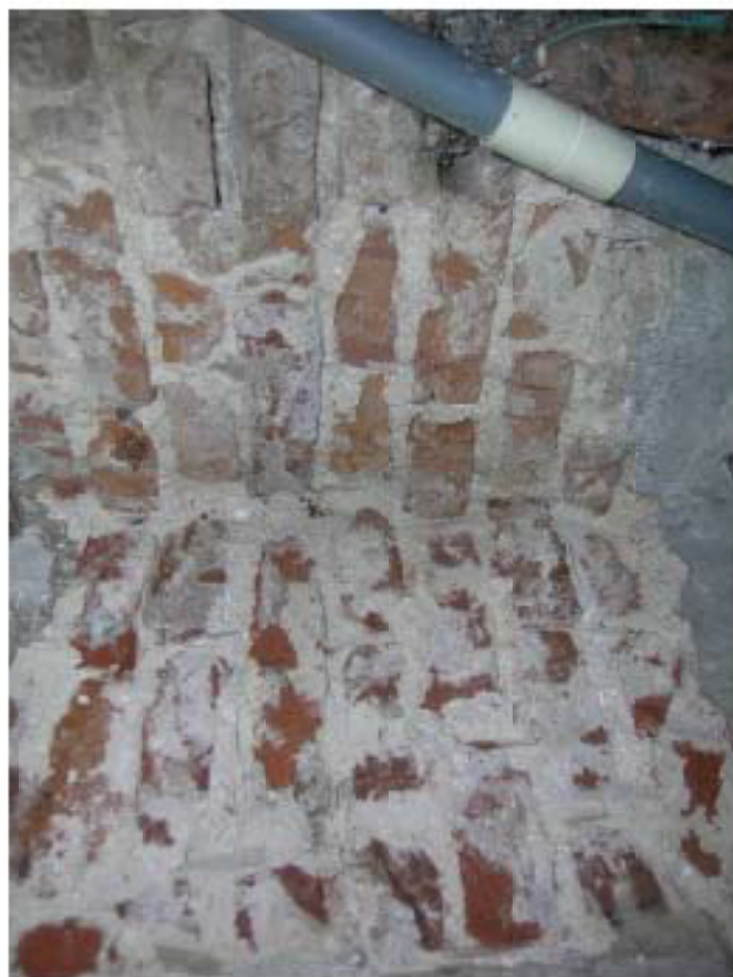
Abbeelding 4. Bouwspoor 3. Rechts het metselwerk van de gangmuur (17,5 x 18,5 x 4 cm met een kerfmaat van 54 cm) en links de voorgevel (17 x 8,5 x 4,5 cm met een kerfmaat van 54 cm), die in de gangmuur is ingebouwd.
