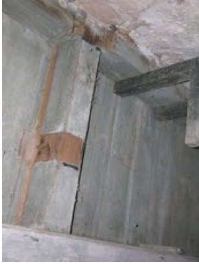
Afbeelding 103. Detail van de raveling bij de voormalige karmolen.
