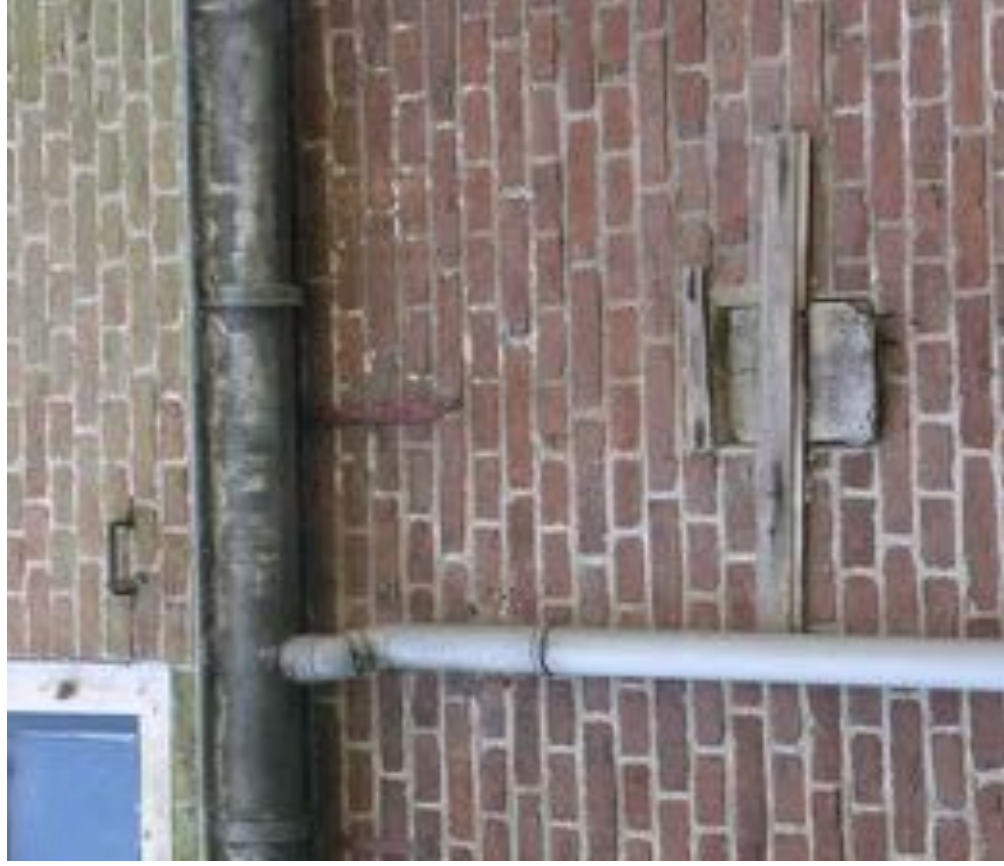
Afbeelding 66. Detail van een klein ventilatieuikje in de zijgevel, vermoedelijk behorende bij de achterliggende voormalige bedstede (thans badkamer).
