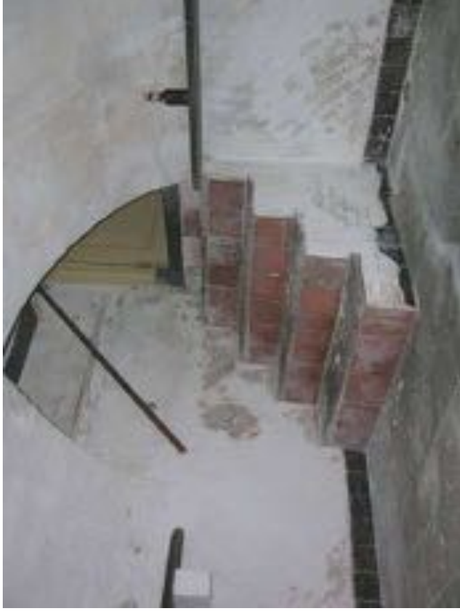
Afbeelding 121. Detail van de vorige afbeelding met de met rode en grijze plavuizen betegelde keldertrap.
