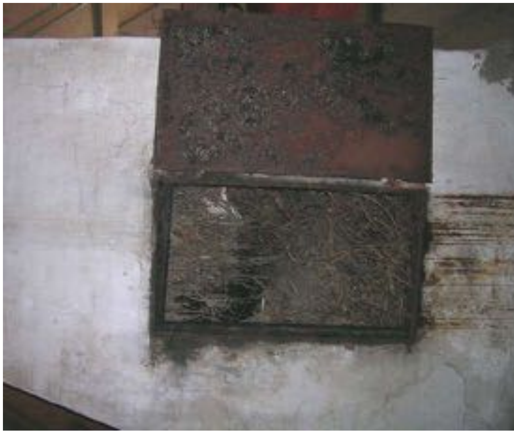
Afbeelding 147. Detail van de vorige afbeelding met het rookluik.
