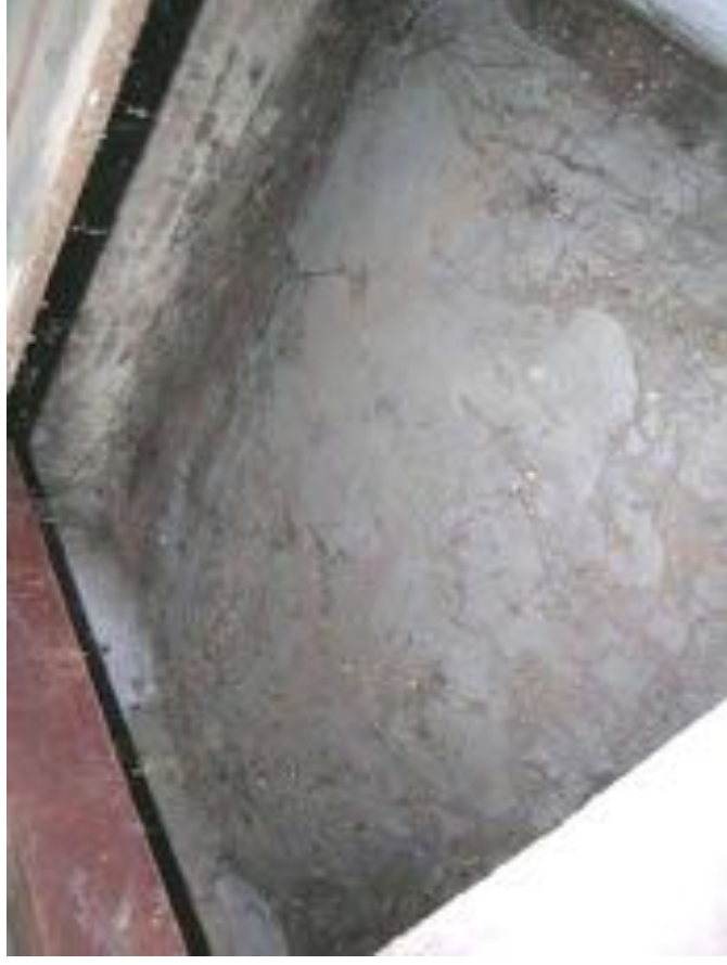
Afbeelding 111. Zicht op de bovenzijde van het tongwelf van de bakoven. Deze was oorspronkelijk toegankelijk vanuit de aangrenzende keukenruimte.
