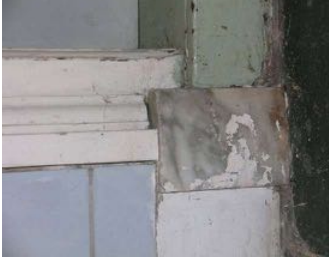
Afbeelding 71. Detail van de plint, die uit geschilderd witmarmer bestaat.
