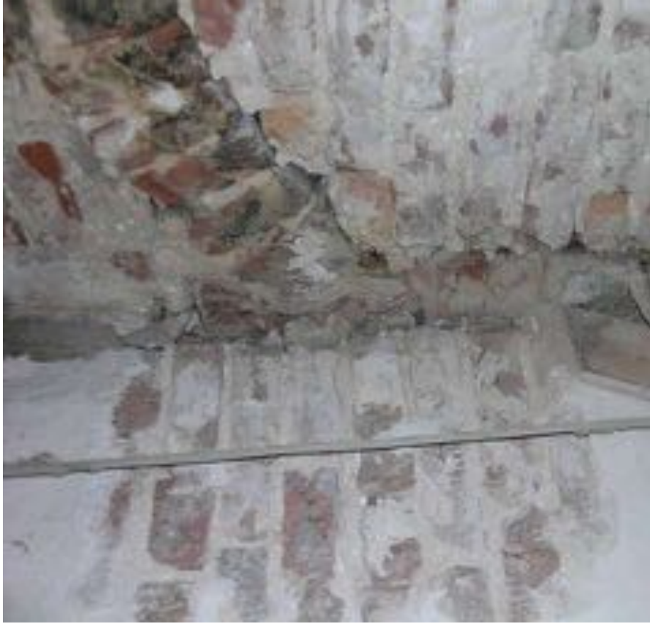
Afbeelding 13. Detail van de vorige afbeelding van bouwspoor 16 met de bouwmuur links en de achtergevel van het voorhuis rechts met de boog.
