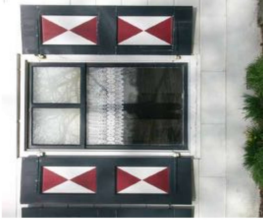
Afbeelding 37. Detail van één van de ramen in het woonhuisgedeelte. De on-derramen – oorspronkelijk van een vierruits roedenverdeling voorzien, be- staan thans uit éénruits ramen.
