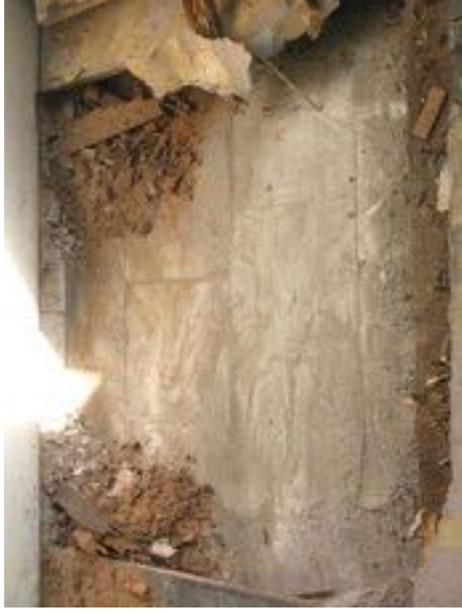
Afbeelding 79. Detail van de plavuizenvloer onder de huidige plankenvloer. Aan de bovenzijde is nog juist een strook witjes als plinttegels zichtbaar.
