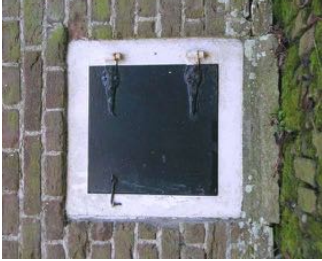
Afbeelding 60. Detail van het kelderlicht met traditionele ijzeren gehengen.
