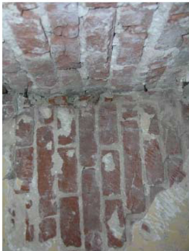
Abbeelding 5. Bouwspoor 4. Links het metselwerk van de achtermuur van het voorhuis (steendikte 4,25 cm met een kerfmaat van 54 cm) en rechts de hierin ingebouwde zijgevel van het achterhuis (steendikte 4,5 cm met een kerfmaat van 62 cm).
