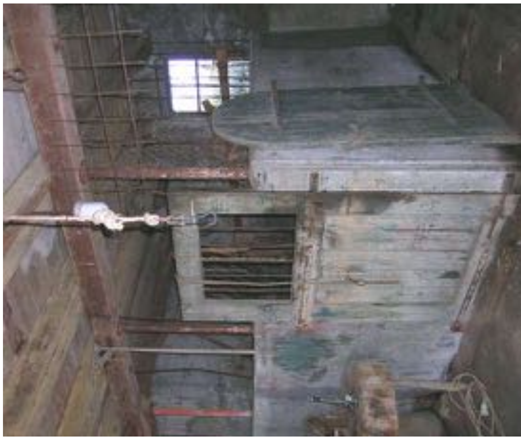
Afbeelding 105. Afbeelding in aansluiting op de vorige met de linker paardenbox en stalen buizen, die de onderslagbalk van de zolderbalklaag dragen.
