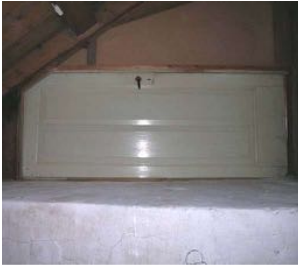
Afbeelding 149. Detail van de uit twee slanke panelen samengestelde zolderdeur. De panelen staan koud tegen elkaar aan en zijn vermoedelijk hergebruikt.
