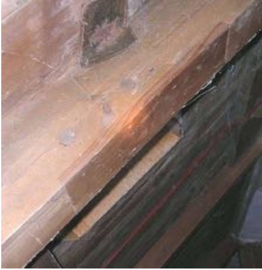
Afbeelding 136. Detail van het kapsant boven de zoldertrap in het voorhuis. De twee toognagels en de uitstukking geven de plaats aan van de vroegere kreupele stijl. Deze is vermoedelijk verwijderd, toen de huidige luie zoldertrap werd aangebracht ter ontsluiting van de – vermoedelijk in de jaren '30 – ingebrachte secundaire zolderkamer(tjes).
