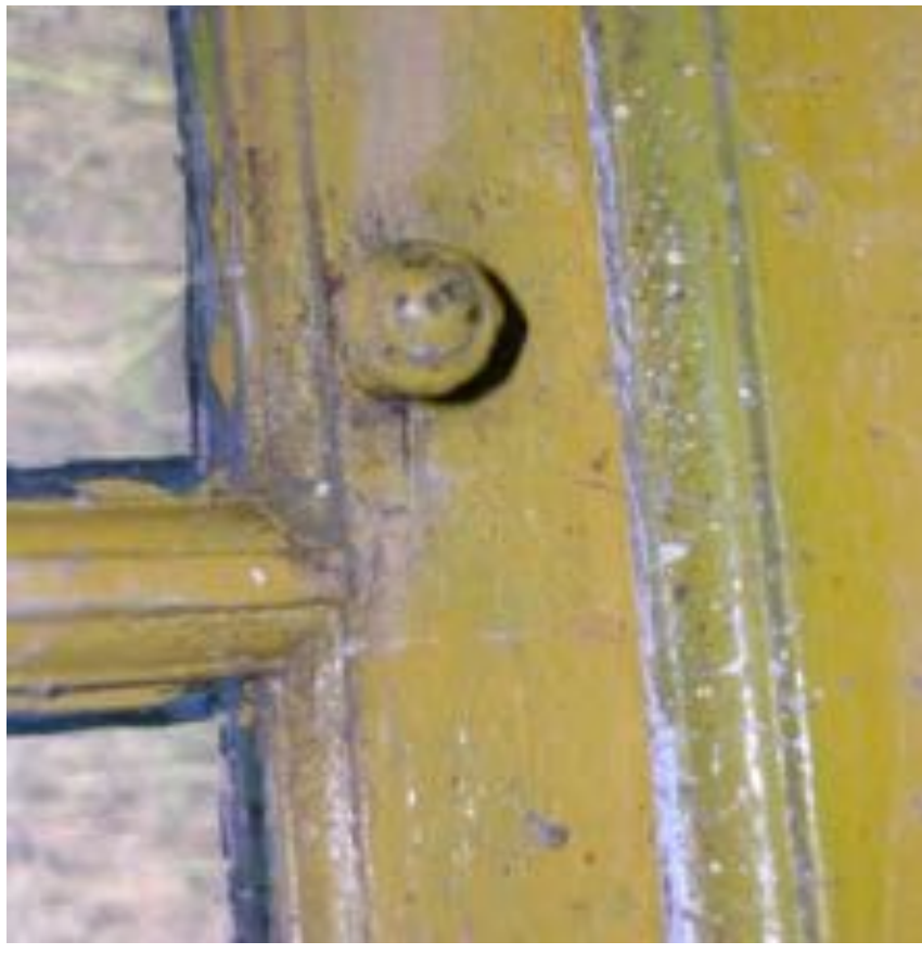
Afbeelding 145. Detail van de vorige afbeelding met de profilering van het raamhout en raamknopje.
