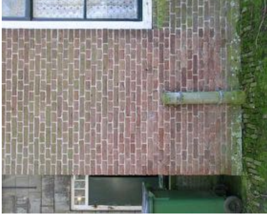
Afbeelding 61. Detail van de hoekoplossing met de drieklezoren.
