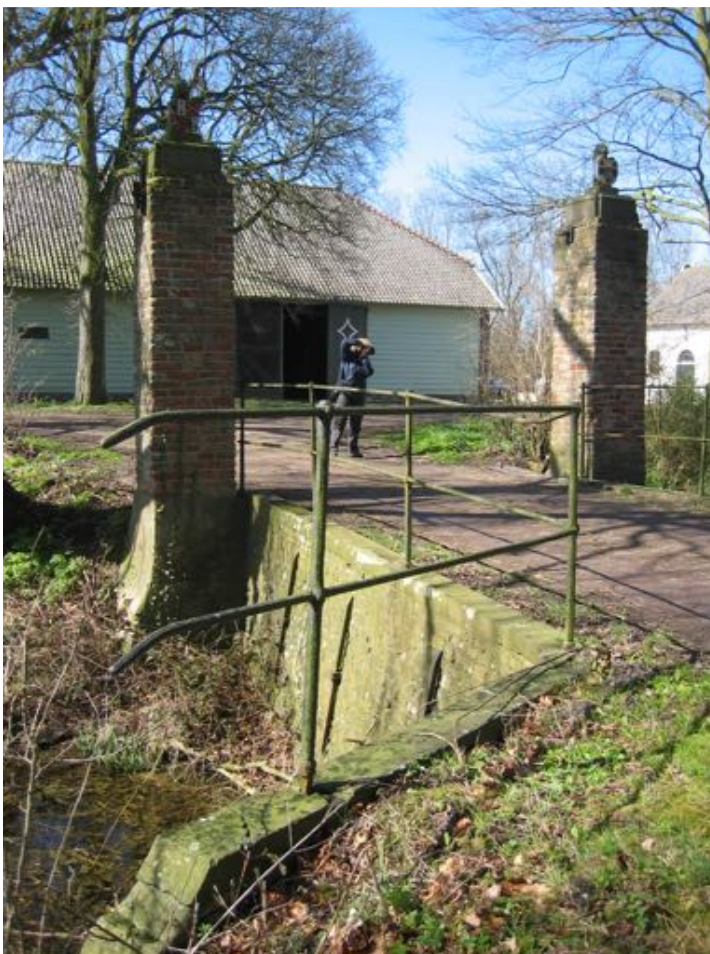
Hekpijlers in de dam in de gracht.
