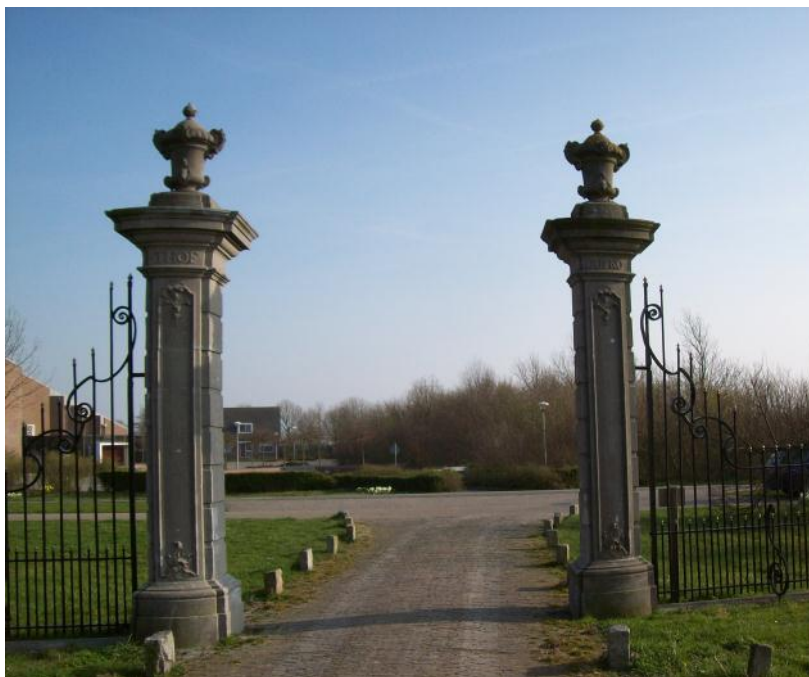
Afb. 2.11 Toegangshek Zeeduin/ Duno aan de Noordweg, gezien vanaf de oprijlaan, naar de Noordweg.
