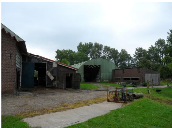
Afb. 6.10 Het erf achter de grote schuur. Links de aangebouwde koestal, rechts de opslagloods en hengstenstal.
